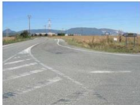
Carretera de Cordovilla que da acceso al camino Esquíroz-Pamplona.
